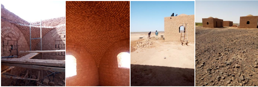
Baumaßnahmen im Herbst 2016/ Winter 2017
